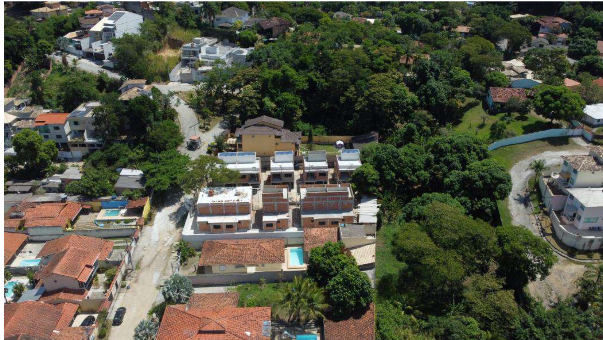
Foto aérea da implantação das Casas (10)
